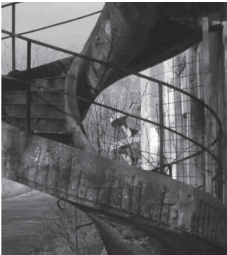
Les escaliers à vis en béton.
