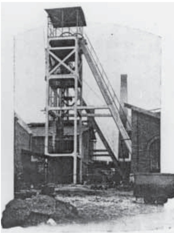
Un des premiers chevalements en béton armé d'Europe : celui du puits d'aérage du siège Espérance de Montegnée (1912). Extrait de la brochure Société Anonyme des Charbonnages de l'Espérance et Bonne Fortune à Montegnées-lez-Liège (Belgique), Liège, 1913.
