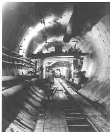
Construction du tunnel sous l'Escaut (1985-1988).
