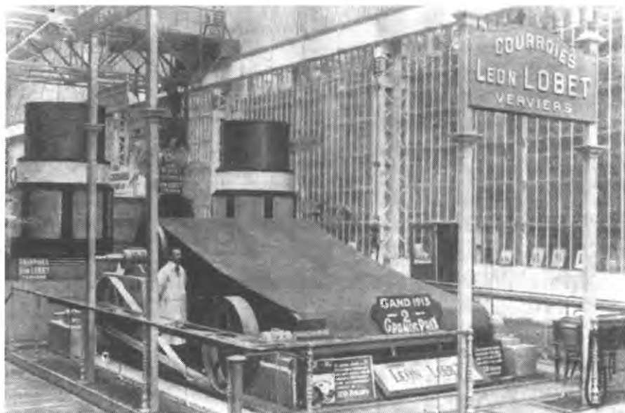
Stand Lobet à l'Exposition de Gand 1913. Courroie double de 3 m de largeur, soudée, sans couture, composée de 120 coupous à courroies.
