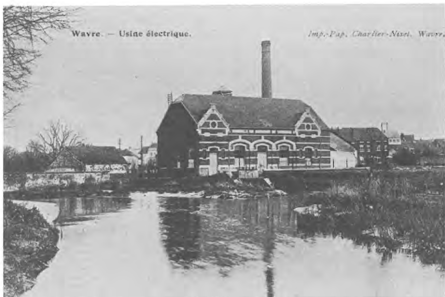
Fig. 1. WAVRE. Usine électrique vers 1907.
