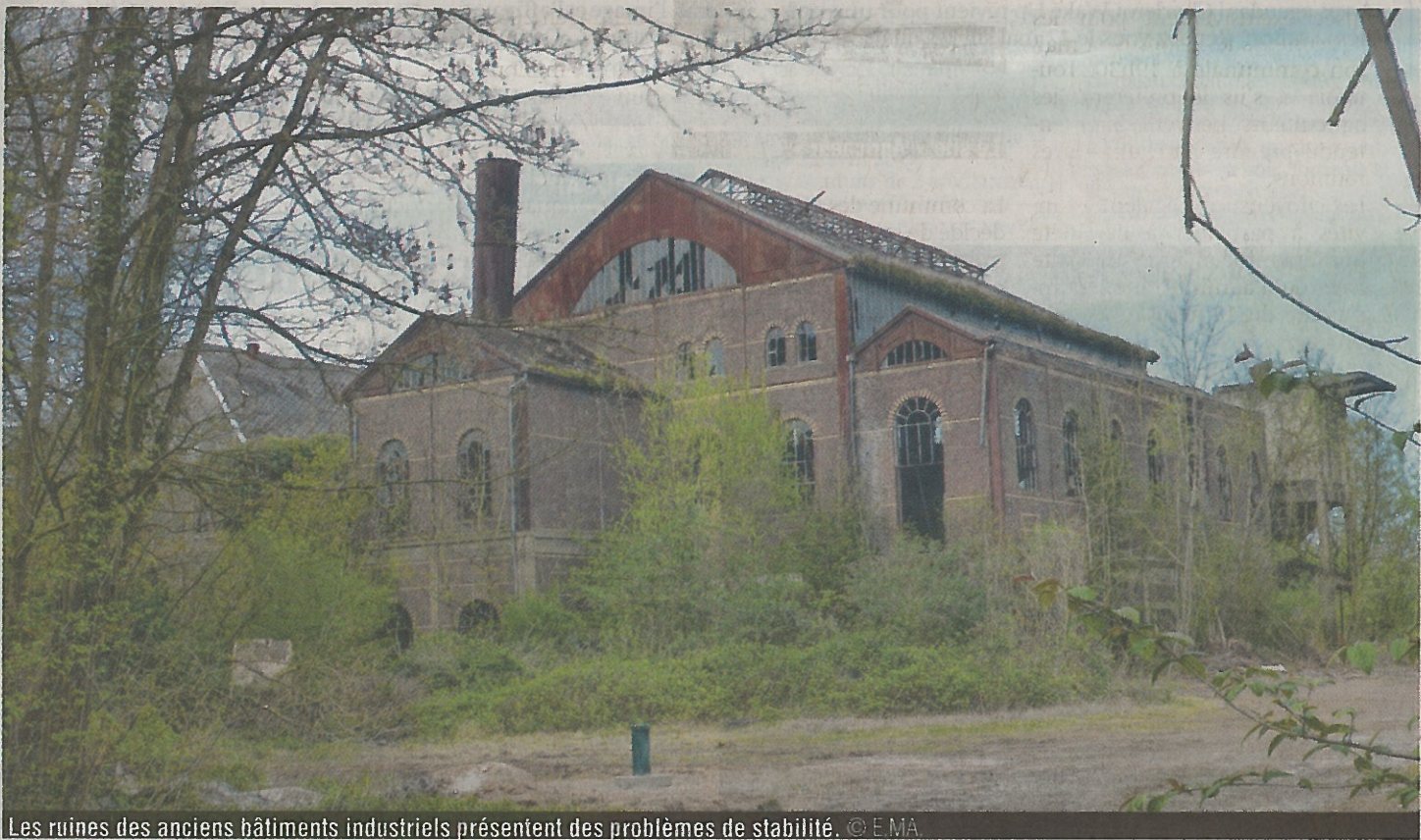
Les ruines des anciens bâtiments industriels présentent des problèmes de stabilité. © E. Ma
