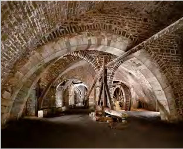
La Grande saline de Salins-les-Bains. Roue hydraulique destinée à l'éclairage de la saumure dans le Grand puits. Ce système de pompage fut mécanisé en 1750 pour remplacer les traditionnels manéges à chevaux. Yves Sancy © Région Franche-Comté, Inventaire du patrimoine. ADAPF, 1985.
