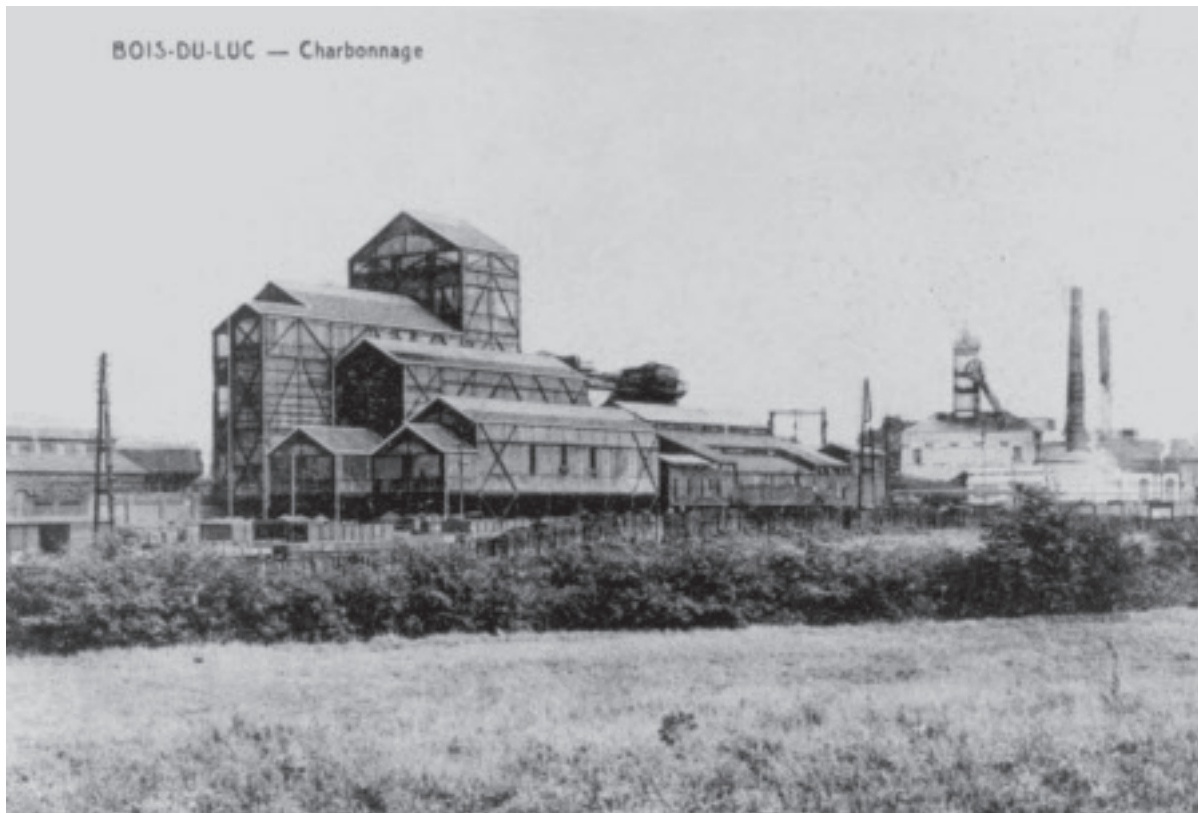
Charbonnage du Bois-du-Luc. À gauche les bâtiments du triage-lavoir (coll. J.-M. Thibaut)
