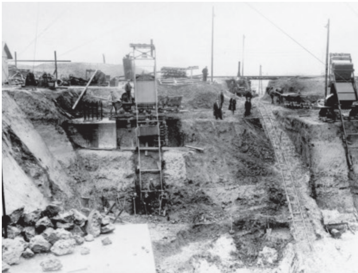
SAICOM, fonds Carbonisation Centrale (collection V. Vincke, creusement des fondations du bâtiment), circa 1929.
