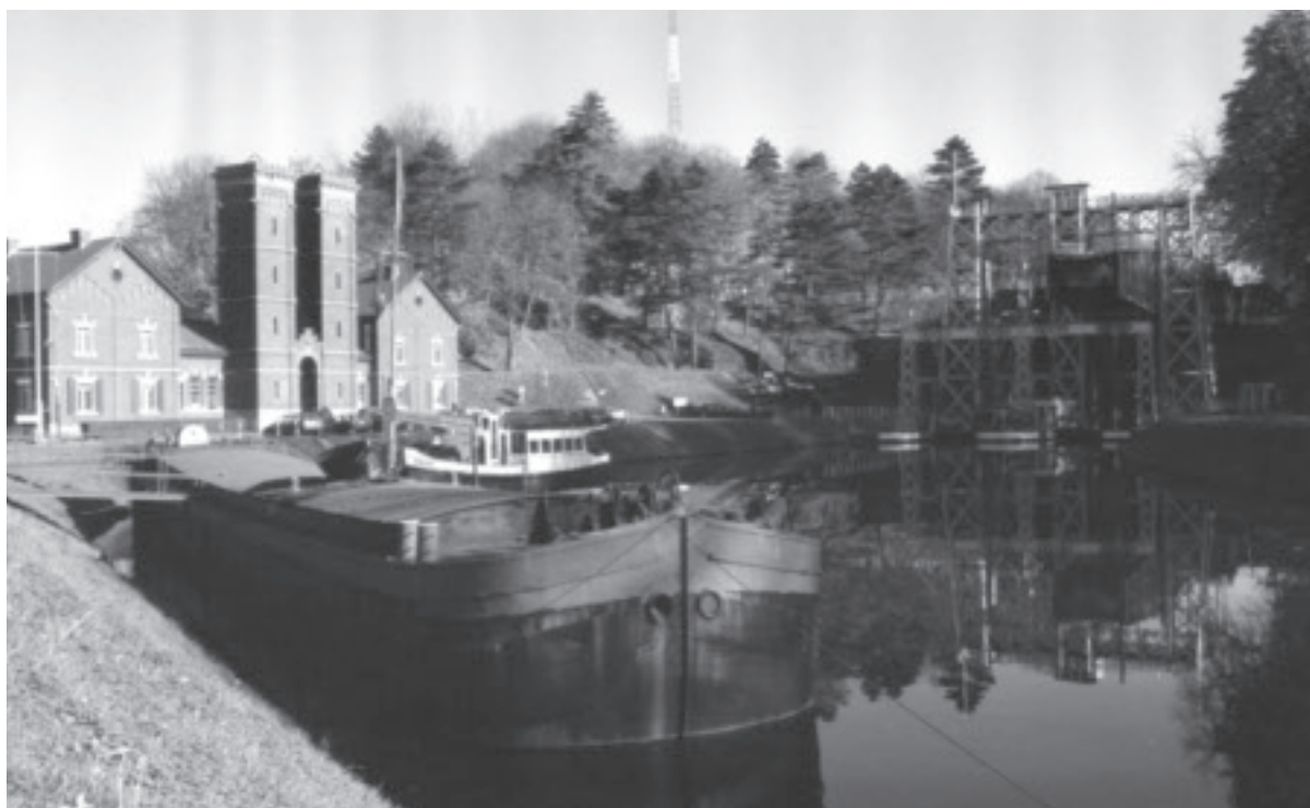
Strepny-Bracquegnies. Le bâtiment des machines et l'ascenseur n° 3 (photo : R. Willame)
