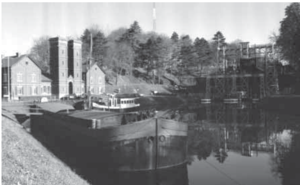
Strepy-Bracquegnies. Le bâtiment des machines et l'ascenseur n° 3 (photo : R. Willame)
