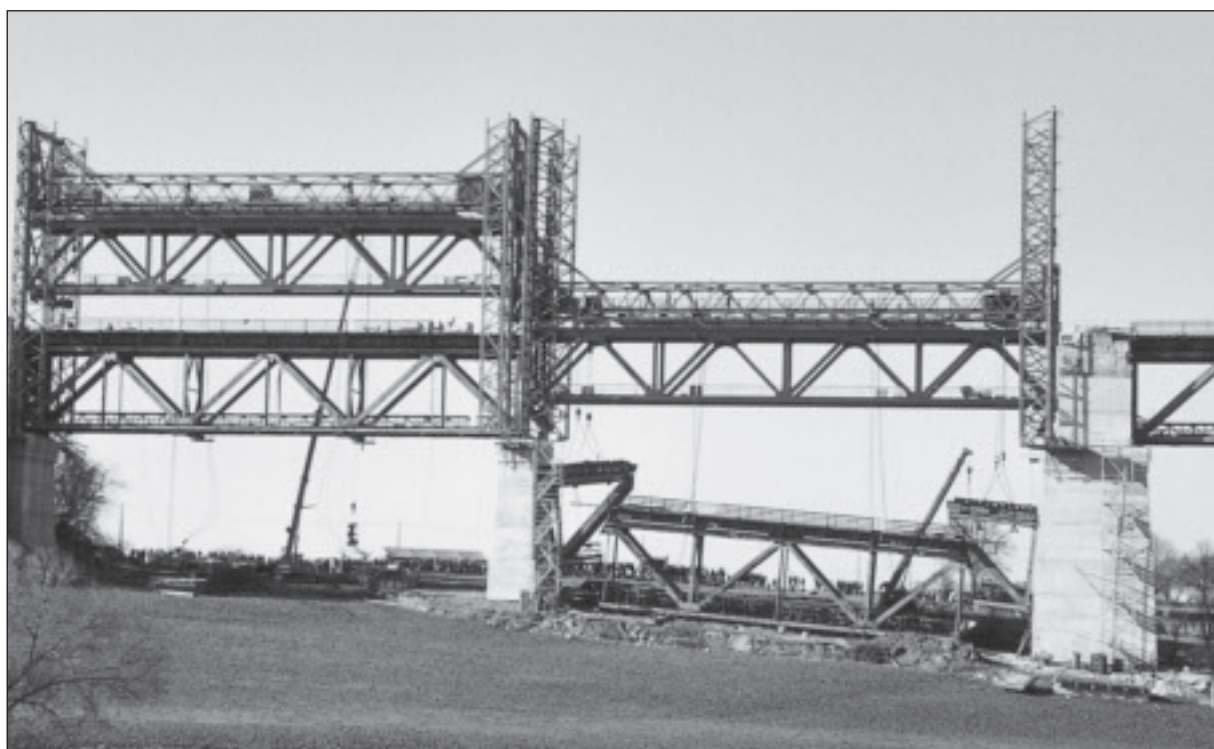
Fig. 16 - Placement du deuxième tablier après démontage de l'ancien (© Jean Defert).
