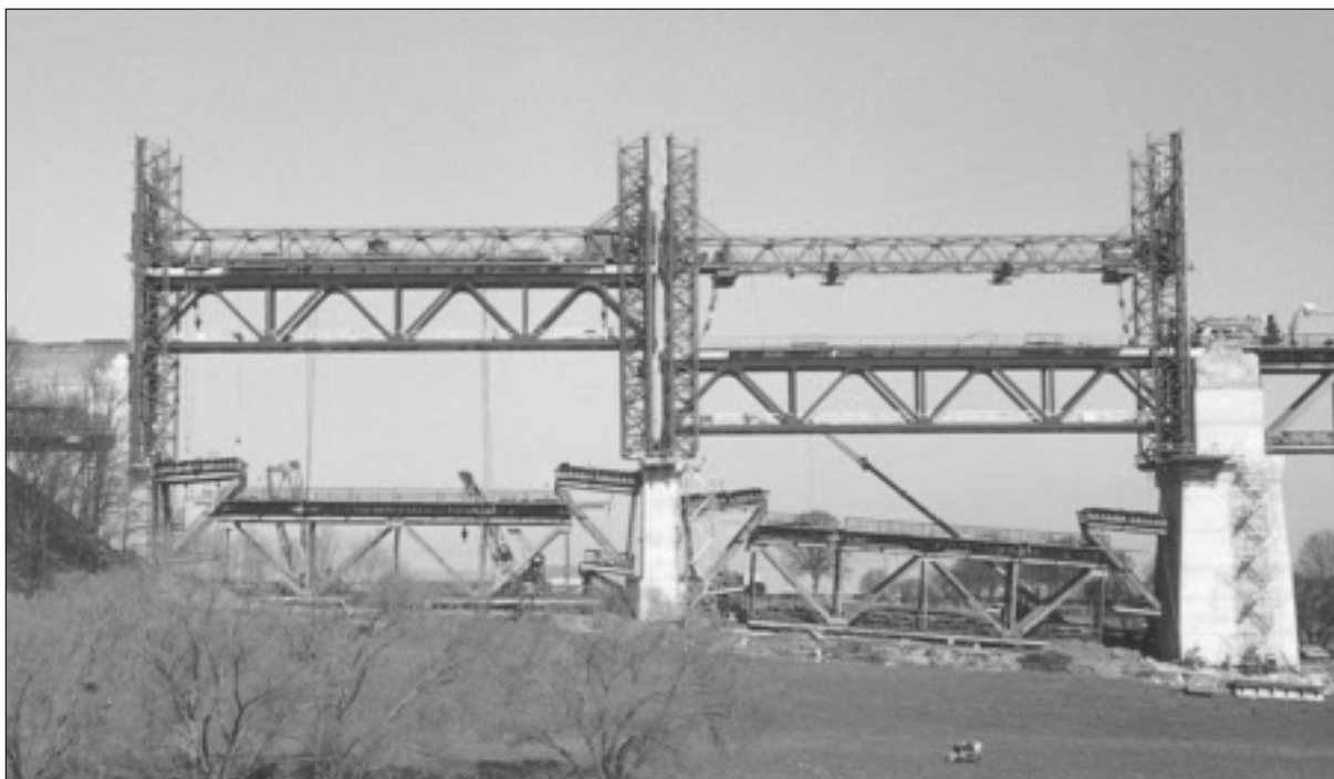
Fig. 17 - Placement du premier tablier alors que le deuxième tablier est en place (© Jean Defert).
