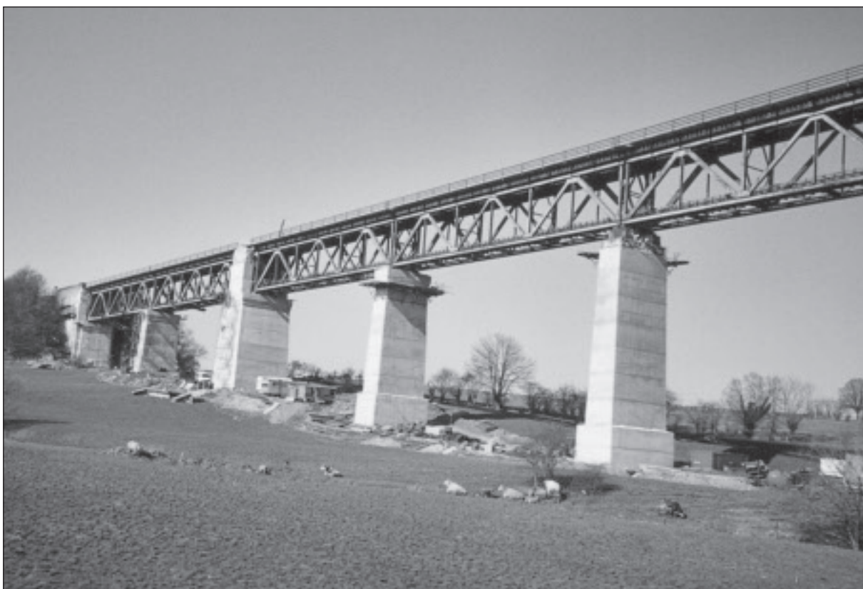
Fig. 12 - Viaduc de Moresnet avant transformation, 15 mars 2003 (© Jean Defér).
