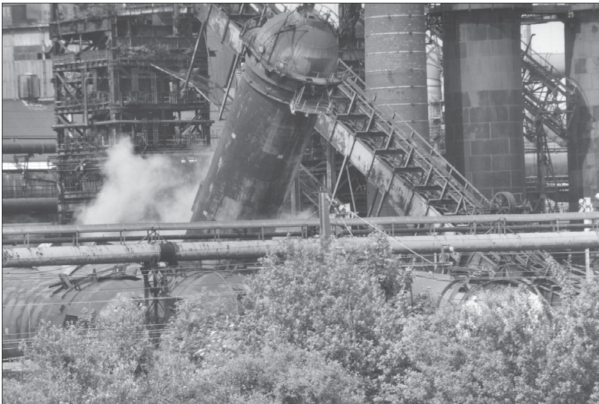
Fig. 5 - Le dynamitage d'un cowper, 28 mai 2003 (© Collection Archives de la Ville de La Louvière).
