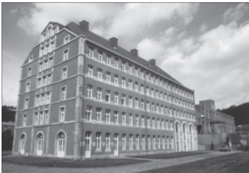
Un bâtiment-phare à Verviers : la filature "Le Chat" du fabricant Simonis, reconvertie en logements sociaux par la Ville au milieu des années 1980. ©P. VIAENE.
