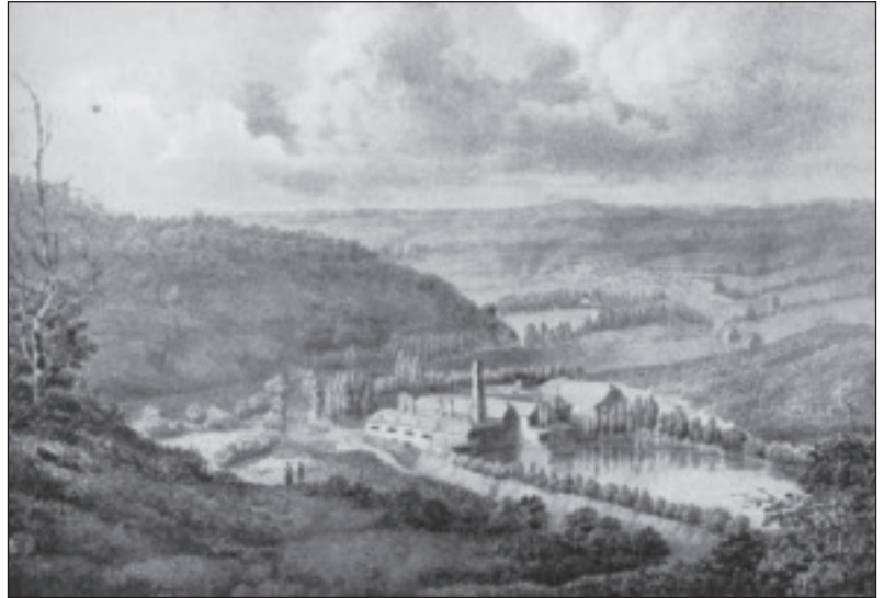
Vue d'ensemble des installations à Pernelle.
