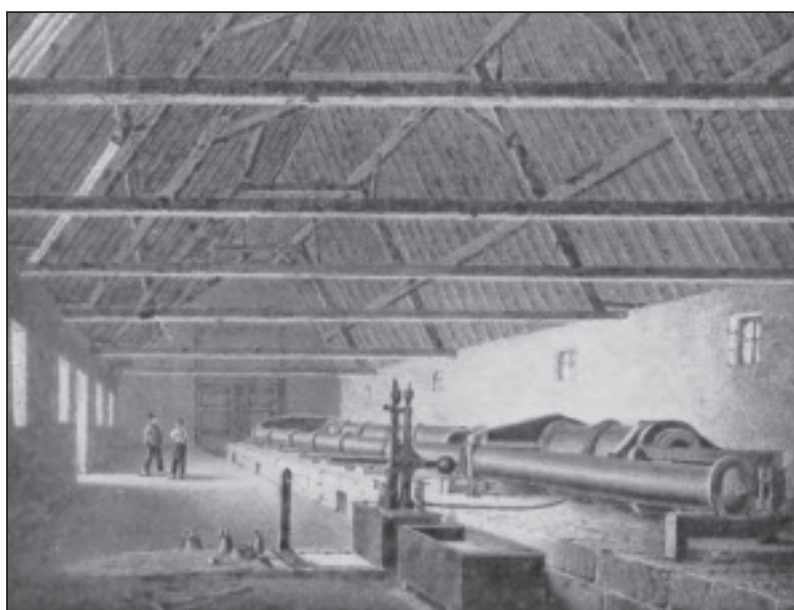
Etablissements de Saint-Roch. La presse hydraulique.
