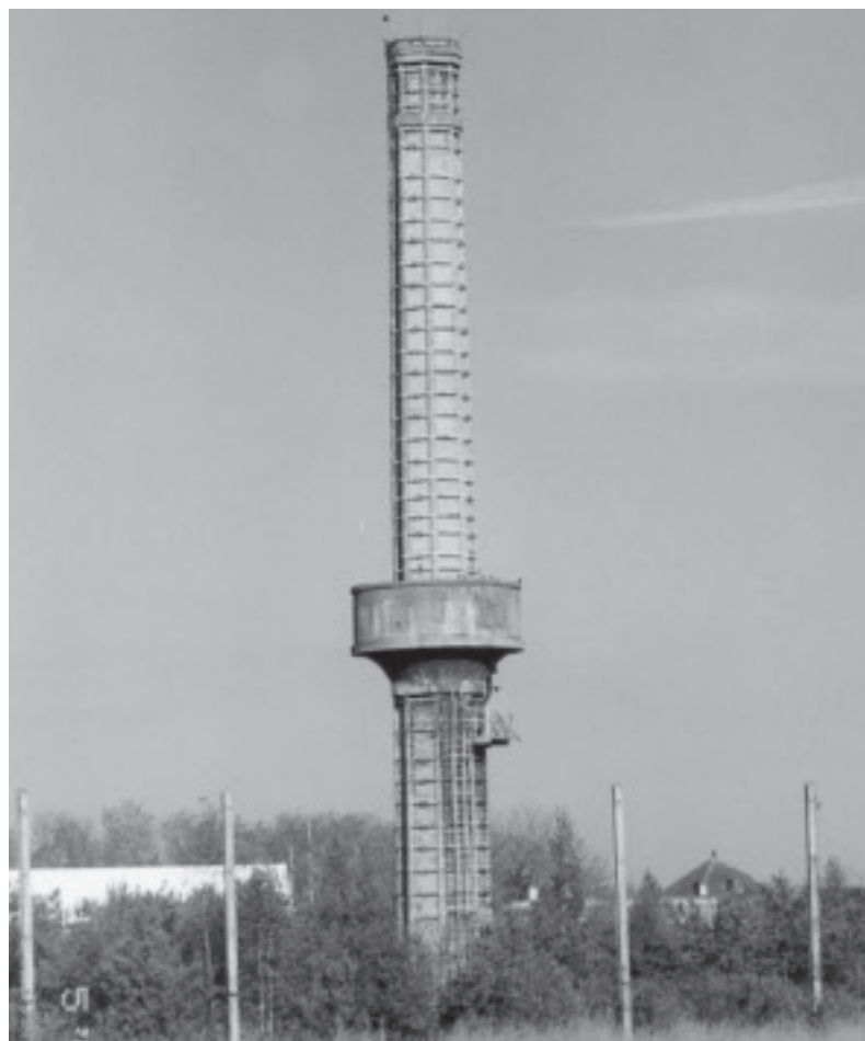
Cheminée en claveaux de béton des laminoirs à chaud de Jemappes, toujours en place avenue Demerbe (cl. de l'auteur).
