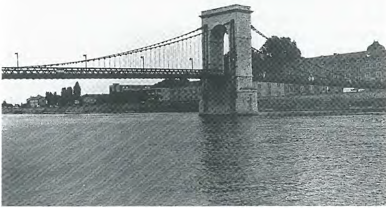
Le pont suspendu de Tournon sur le Rhône, dû à Marc Seguin (1825).
