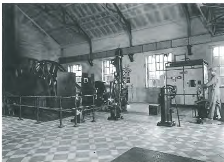
La machine d'extraction du puits n°2 de la fosse Delloye au Centre Historique Minier. © Centre Historique Minier de Lewarde.
