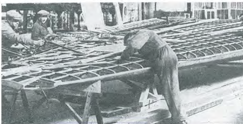
Construction d'un avion : le squelette de l'aile. Dans le prolongement de l'aileron, le volet d'intrados. (L'Aviation marchande, p. 18).
