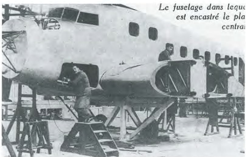
Construction d'un avion : le fuselage dans lequel est encastré le plan central. (L'Aviation marchande, p. 18).
