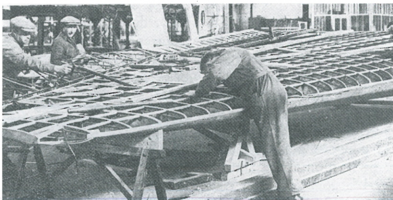
Construction d'un avion : le squelette de l'aile. Dans le prolongement de l'aile, le volet d'intrados. (L'Aviation marchande, p. 18).
