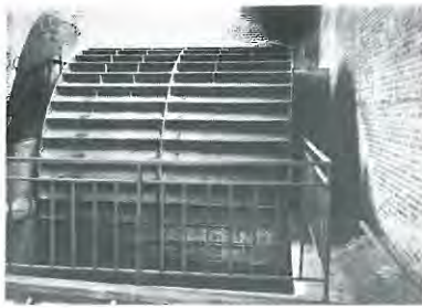
3. Dans sa fosse protégée par un garde-corps, la roue à aubes placée devant les coursiers (cachés par la roue). (Photo vers 1914 - Document Institut Provincial d'Hygiène et de Bactériologie du Hainaut - IPHBH, cliché Association des Montois-Cayaux)
