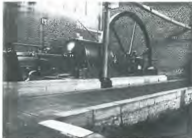
5. La première pompe à vapeur de 45 CV et son volant d'environ 5,80 m de diamètre. (Photo vers 1914 - Doc. IPHBH / Montois Cayaux)
