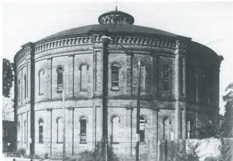
11. Troy (New-York). Gazomètre d'une capacité de 300.000 m 3 construit en 1873.
