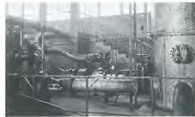
8. Les pompes centrifuges électriques refoulaient des eaux sous pression dans le réservoir-tampon visible à droite. (Photo vers 1930 - Document REM)
