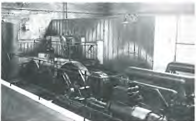
4. Les pompes hydrauliques de 25 CV entraînées par la roue à aubes qu'on devine derrière la paroi vitrée. (Photo vers 1930 - Document Régie des Eaux de la ville de Mons, REM)
