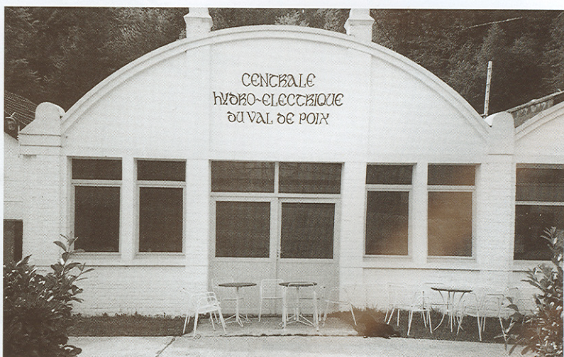
2. Centrale hydro-électrique du Val de Poix. Photo J. Crul.
