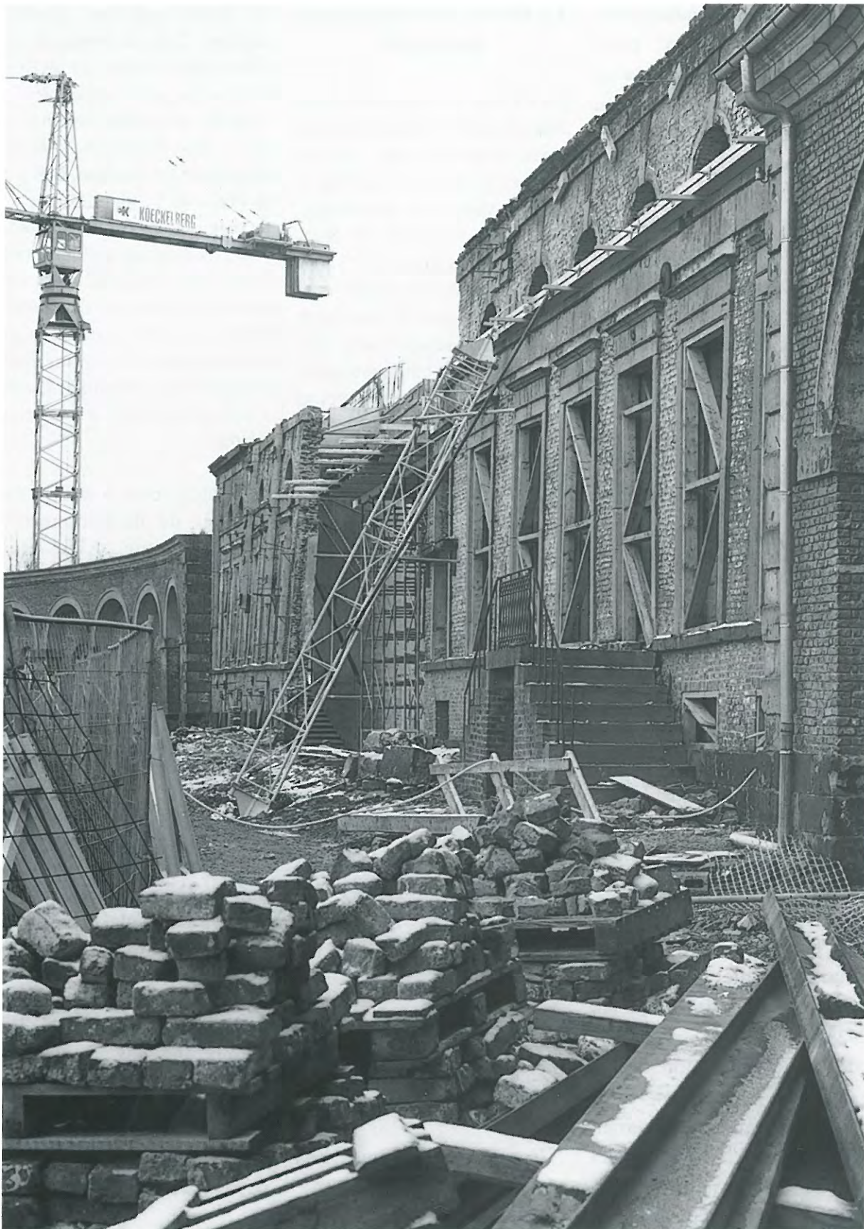
5. Grand-Hornu : chantier du futur "Musée des Arts Contemporains". Photo Grand-Hornu Images ASBL.
