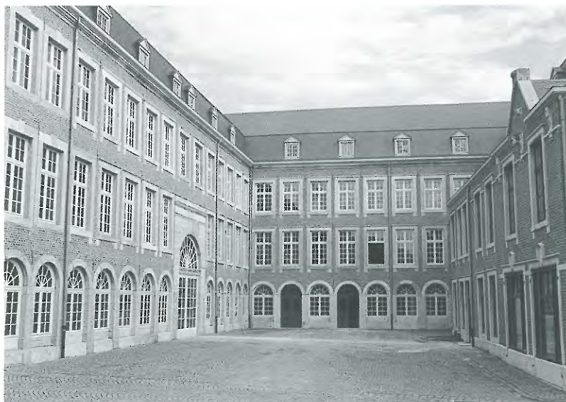
6. Bâtiment néo-classique rénové du Centre touristique de la Laine et de la Mode de Verviers. Cl. Musées communaux Verviers.
