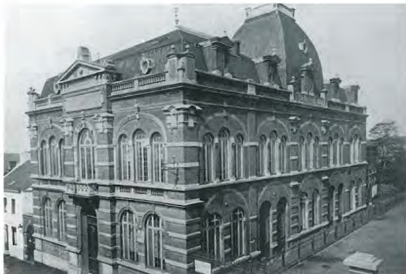
10. Ancien bâtiment de l'École industrielle de Morlanwez (Cliché M. Lechien, Musée Royal de Mariemont).
