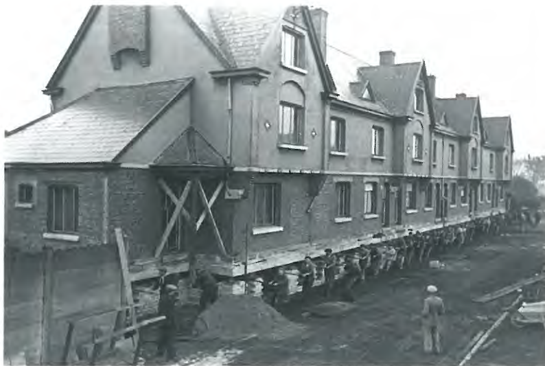
6. Cité Sartis. Relèvement du bloc des 10 maisons pour employés. Copyright idem.
