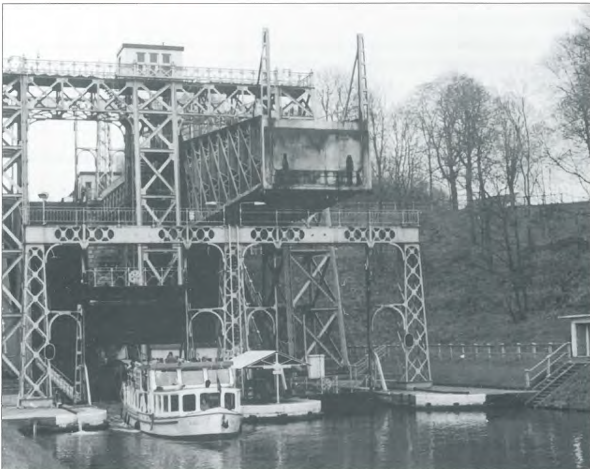
8. Franchissement de l'ascenseur n° 3 du Canal du Centre.
