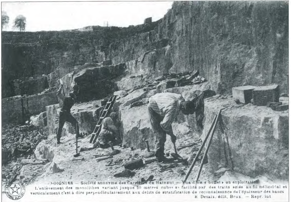
14. Buffet d'extraction des carrières du Hainaut à Soignies (carte postale du début du siècle). Collection du Musée de la Pierre à Maffle.
