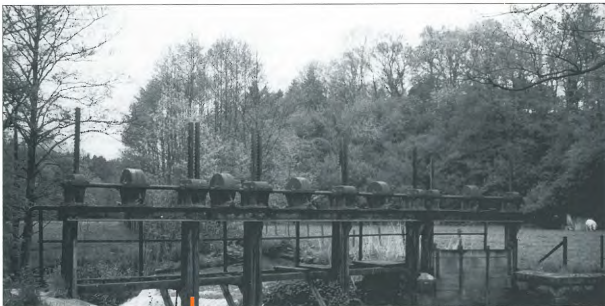
6. Portique à vannes à l'entrée du bief d'alimentation de la machine de Corbeaumont (Cliché QVW).
