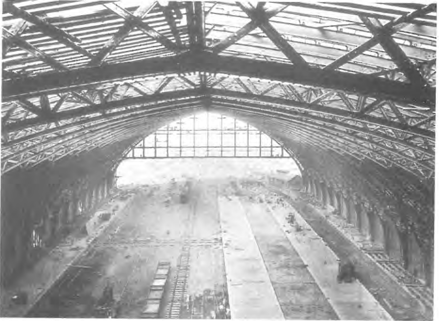
fig. 4 : Halle de la station Saint-Pancras à Londres. Construite en 1868 par W.H. Barlow, cette architecture montre bien la part de l'ingénieur dans la recherche de typologies adaptées aux nouveaux besoins et moyens. Le matériau métallique est éminemment novateur par ses qualités physiques. Ce matériau est pourtant invisible depuis l'extérieur, camouflé par une façade-paravent éclectique. Deux mondes s'interpénètrent sans pour autant s'exclurent, celui du poids d'autorité de l'histoire et celui de la novation.
