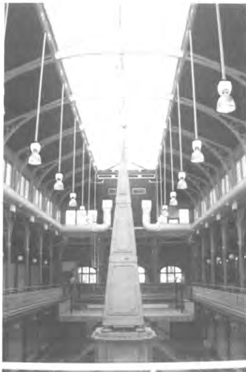
Photo 3 - L'intérieur du marché après rénovation.
