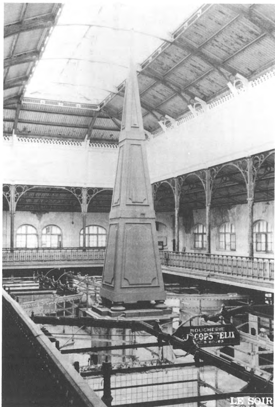
Photo 2 - Vue intérieure du marché en 1988. (Photo «Le Soir»).
