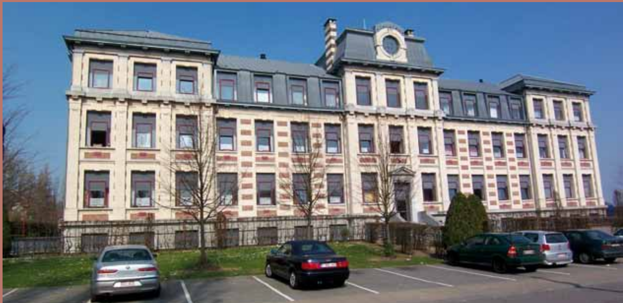
Montignies-sur-Sambre, Sambre et Moselle, Bureaux après réhabilitation et reconversion © Béatrice Garny
