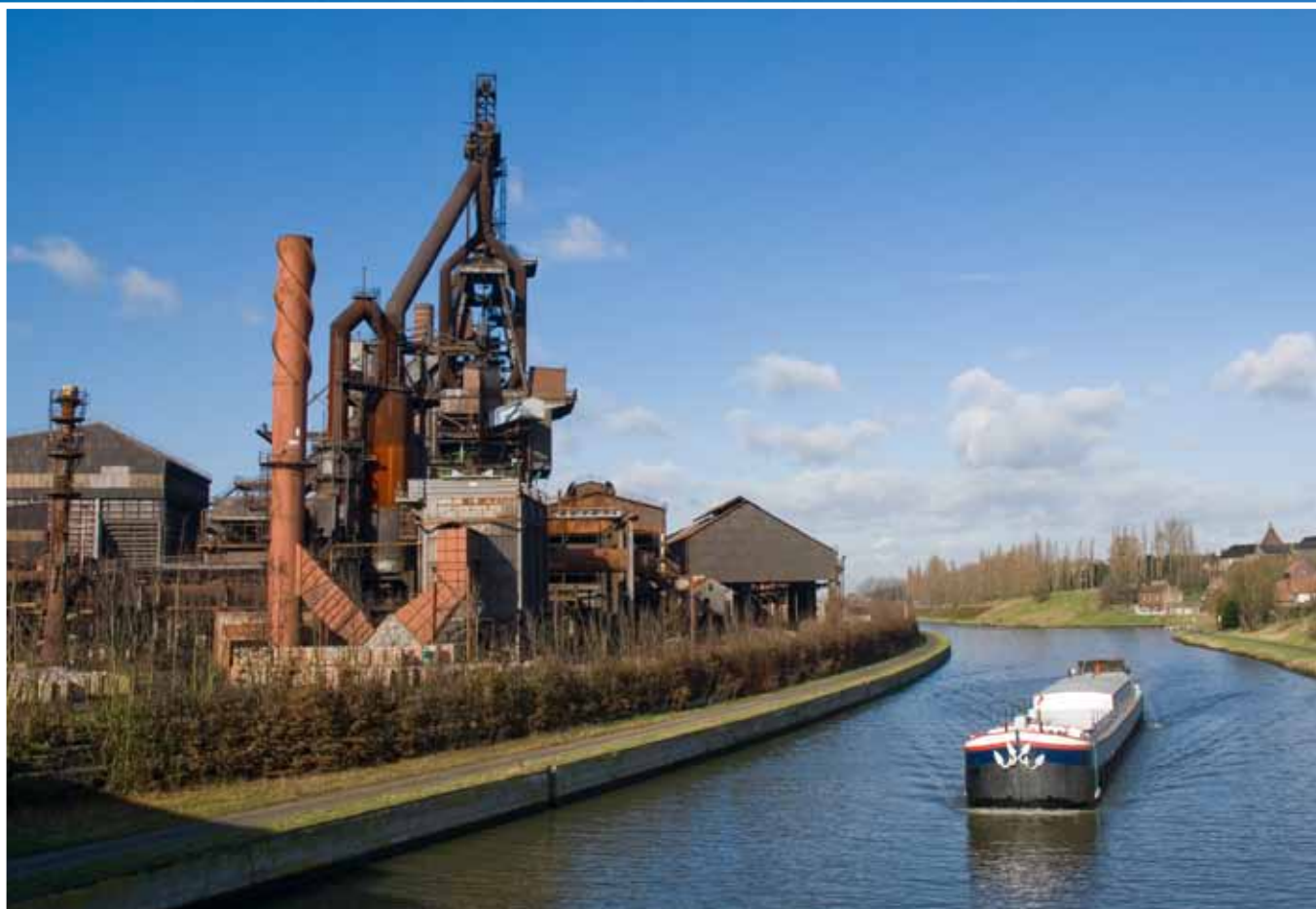
Le haut fourneau 6, un des derniers investissements des Forges de Clabecq, trône toujours dans le paysage. Il est appelé à disparaître prochainement. © Gilles Durvaux
