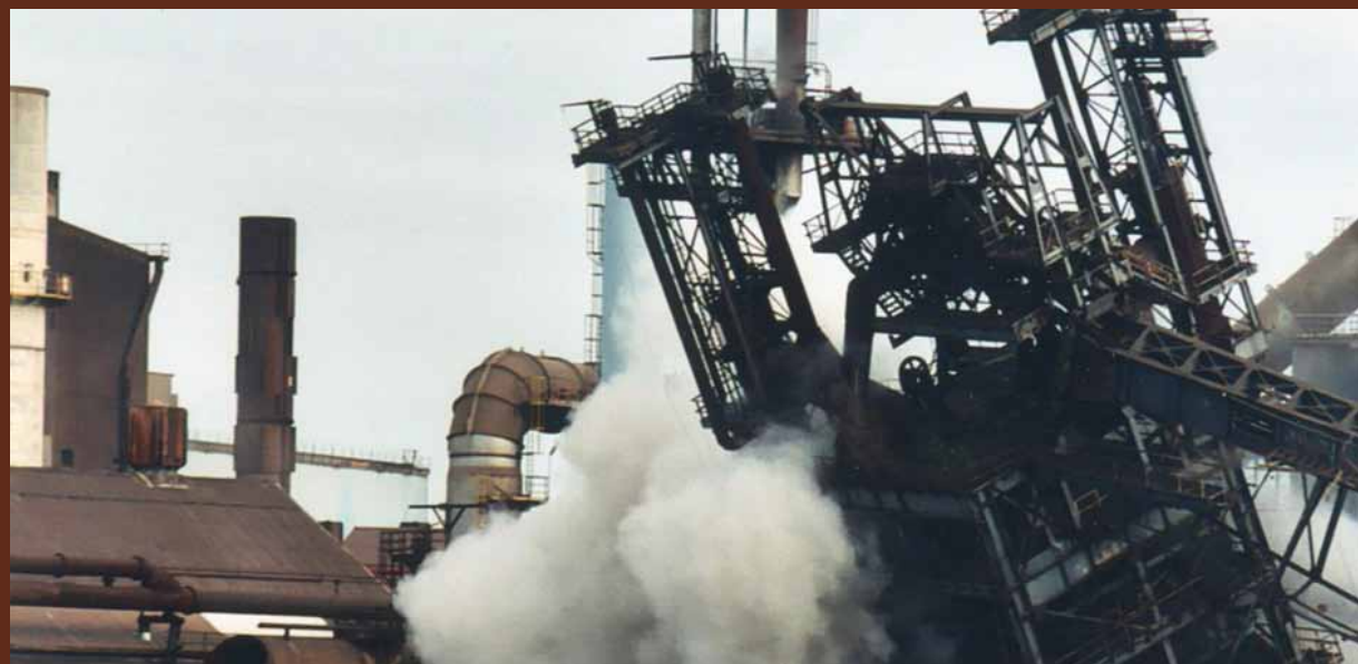
Les opérations de dynamitage du site des hauts fourneaux, 2003-2004 (coll. AVLL)
