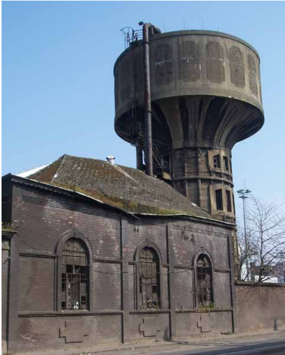
Marchiennes, La Providence - salle des pompes et château d'eau en 2011 © André Lierneux
