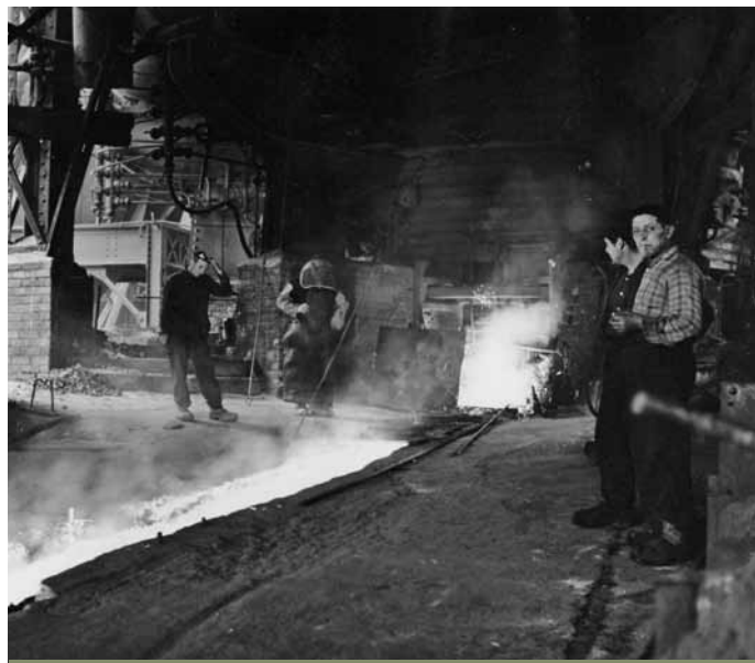
Fondeurs au plancher de coulée du haut fourneau 3 en 1969. Ce haut fourneau est demeuré dans son état d'origine jusqu'à son extinction en 1972 © Collection Roberto Perna
