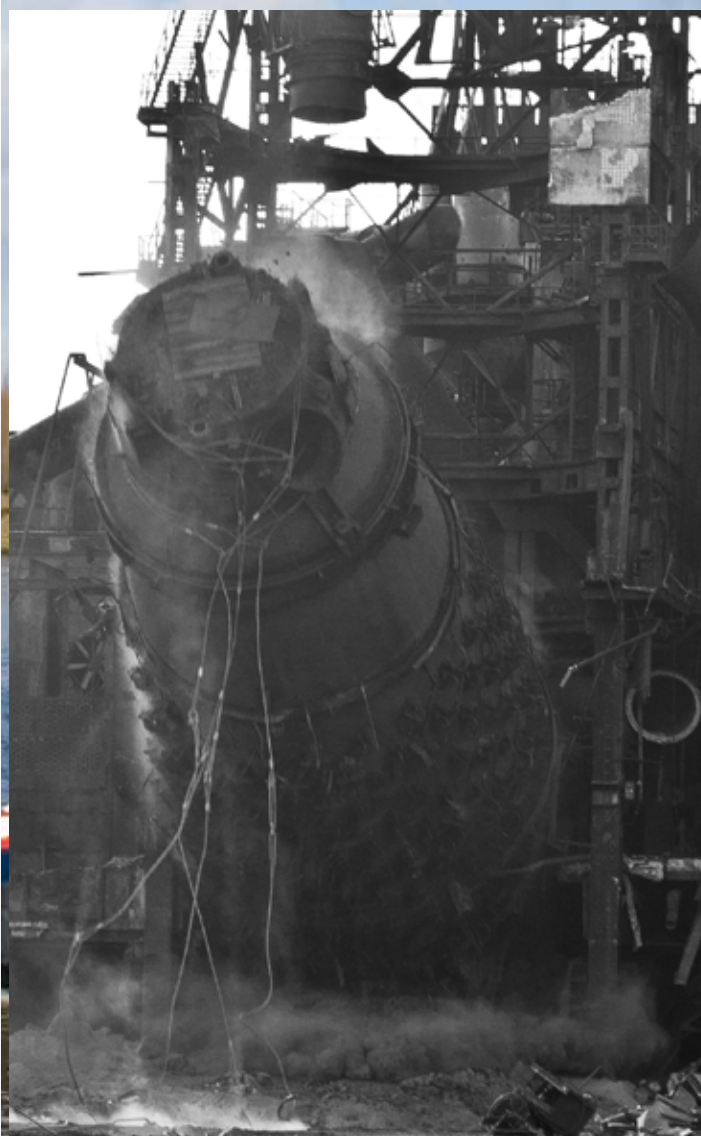
Le 3 avril 2010, la cuve du haut fourneau 1 est basculée © Gilles Durvaux
