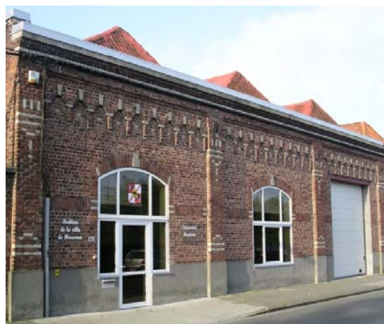
Fig. 3 : Les Archives de la Ville de Mouscron, 120A rue du Petit Pont (cliché Cl. Depauw).
